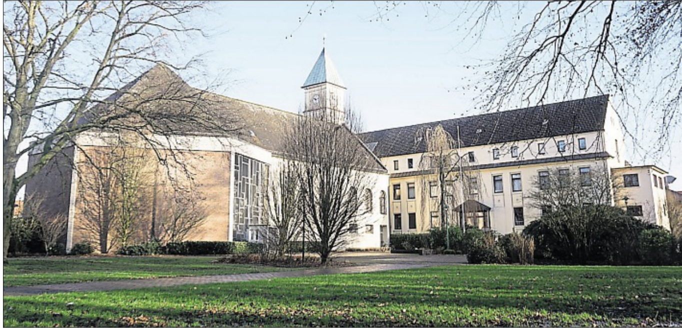
Das Verwaltungsgebäude der Johannesburg in Surwold-Börgermoor.
